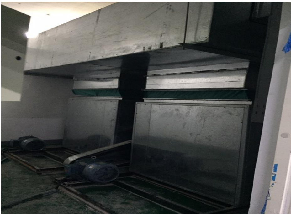
图 2 地下车库风机房
